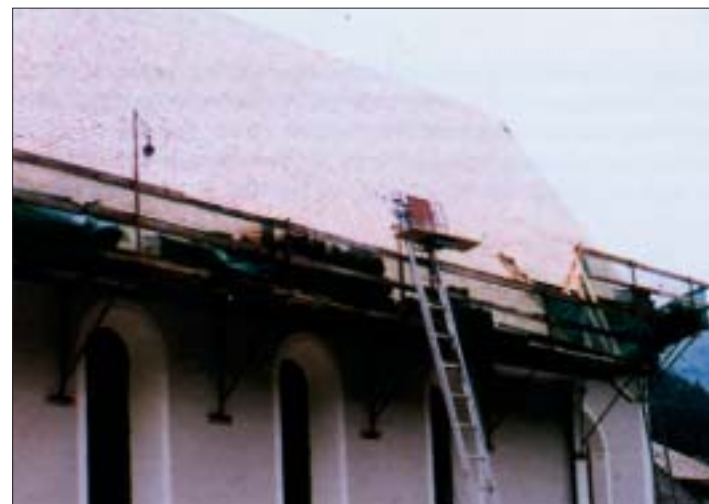
Kongsolgerüst als Dachfanggerüst mit Seitenwehren und Schutznetz
