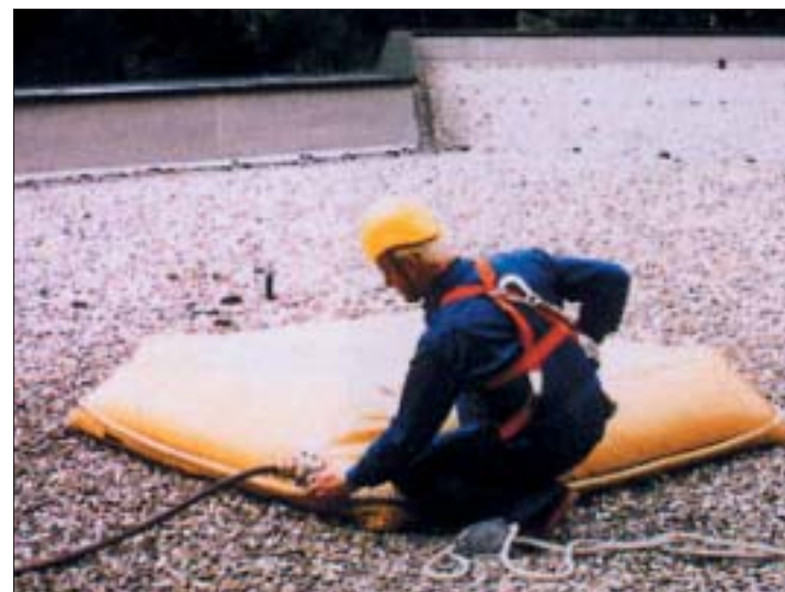
Wassergefülltes Sicherungskissen als Anschlagpunkt für persönliche Absturzsicherung auf Flachdächern
