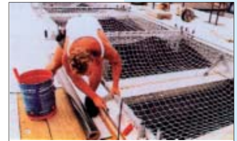
Sicherung von Dachöffnungen
