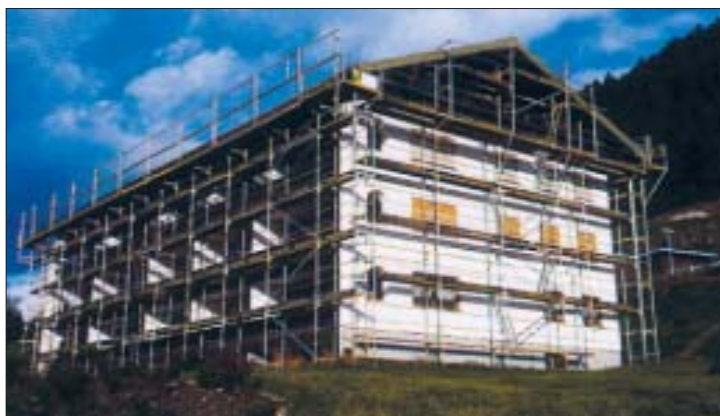
Stahlrohrgerüst als Arbeitsgerüst für Dacharbeiten mit engmaschigem Gitter als Seitenschutz und Sicherung im Giebelbereich
