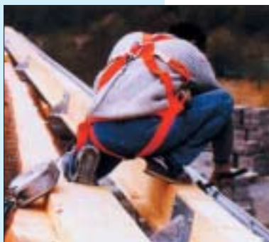
Einsatz eines Höhensicherungsgerätes. Der Befestigungspunkt darf nicht tiefer als die zu sichernde Person liegen
