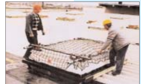
Sicherung einer Oberlichte
