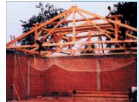
Unterspannte Fangnetze dienen nicht nur der Sicherheit bei Zimmermannsarbeiten, sondern auch bei offenen Dacheindeckungen (z. B. Hallendachkonstruktionen)
