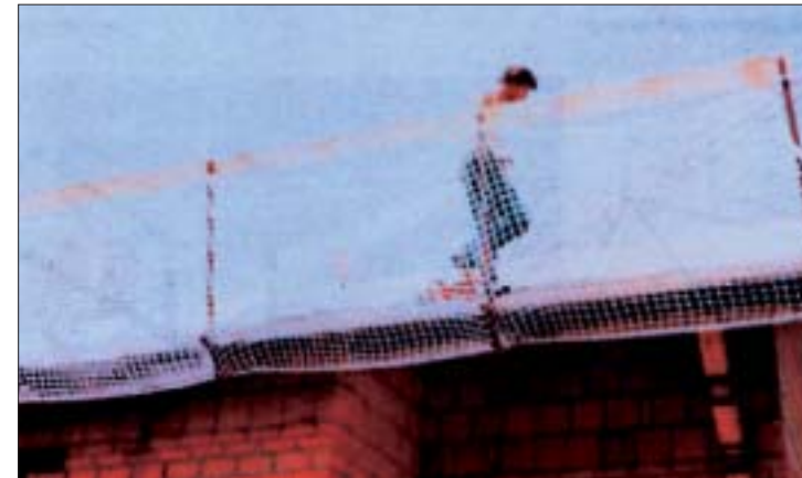
An den Sparren befestigte Konstruktion mit durchgezogenem Netz
